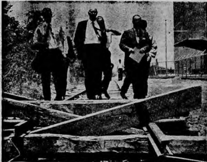
Aquí se hará la interconexión de las vías férreas del Pacífico y del Atlántico. En la foto el Asistente de la Gerencia de la Northern Railway Company, Sr. O. Johnston, el Lic. Rafael Angel Rojas y directores del Ferrocarril al Pacífico cuando visitaron ayer el lugar donde se hará la unión en Alajuela. en compañía de Directores; Gerente y altos funcionarios del Ferrocarril Eléctrico al Pacífico. (Foto Liza no).
